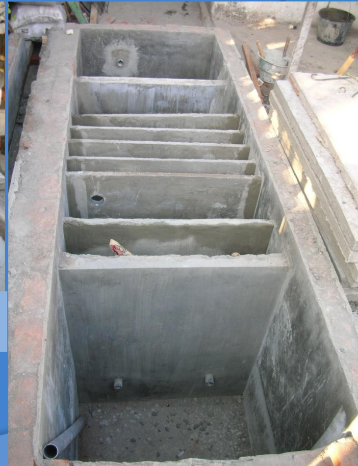
Konstruksi Reaktor Grey Water
