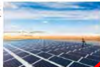
イビデンの太陽光発電設備
