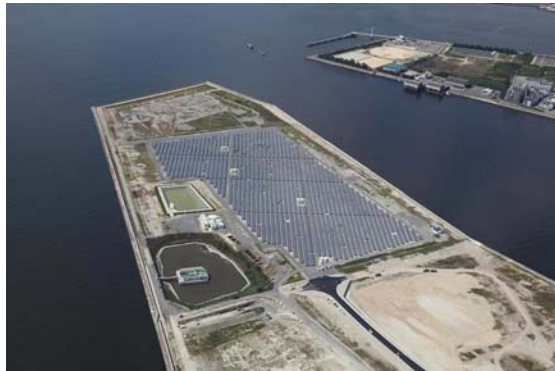
エコひょうご尼崎発電所
