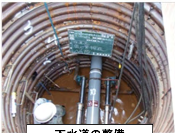
下水道の整備
