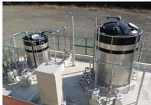
桂川清流センター内に、リン除去設備を設置
