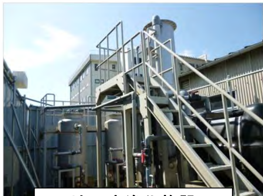
地下水浄化施設
