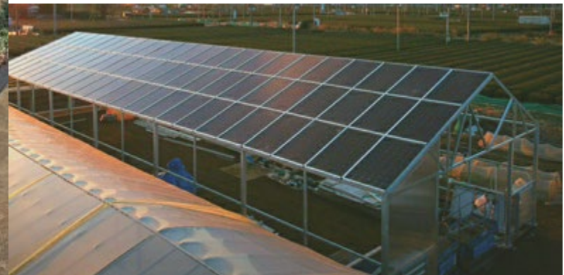
（写真出所：日本パワープラント株式会社）
