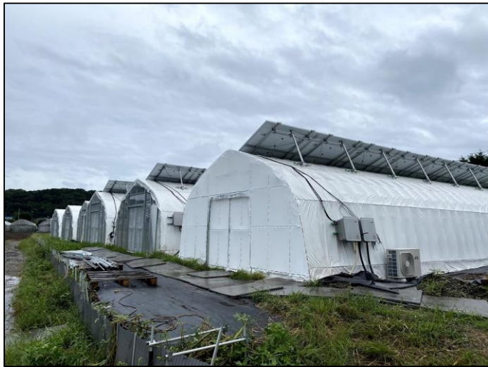
断熱ハウスと一体化し自家消費（東京都瑞穂町） 出所：『太陽光によるシイタケ栽培、「断熱・再エネハウス」』 2021.11.30 日経BP メガソーラービジネス
