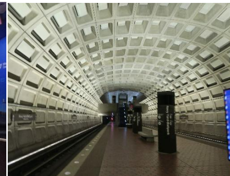
メトロ駅構内
